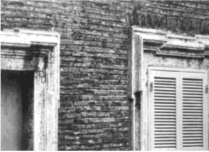
14. Cortina esterna in corrispondenza delle finestre del terzo livello. Le diversità di esecuzione sono dovute a fasi costruttive differenti.
